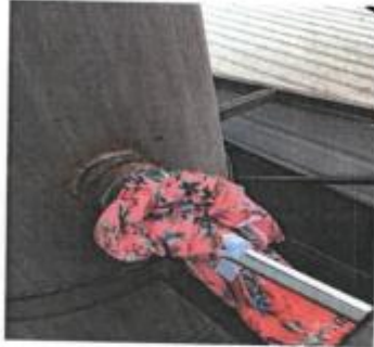
400 万大卡导热油炉 (新)、 60h 燃天然气锅炉废气监测点
